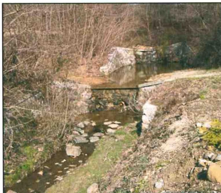
Foto 4.6: Bacino di sedimentazione realizzato lungo il Torrente Piana per ridurre i fenomeni di trasporto solido.
