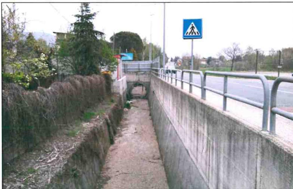
Foto 4.3: Nuovo attraversamento realizzato sul Fosso Colatore del Pilone, per permettere l'accesso all'area da Via Val della Torre.
