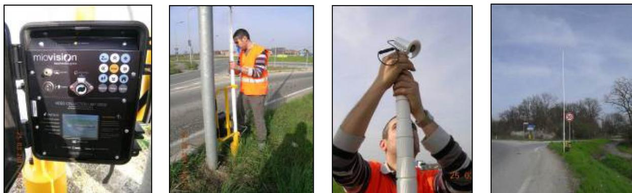
Per quanto concerne invece le telecamere ad infrarossi, tali apparecchiature consentono un rilievo ottimale anche in condizioni di illuminazione non adeguata. Vengono montate all'interno di box a tenuta stagna, al cui interno trovano collocazione
