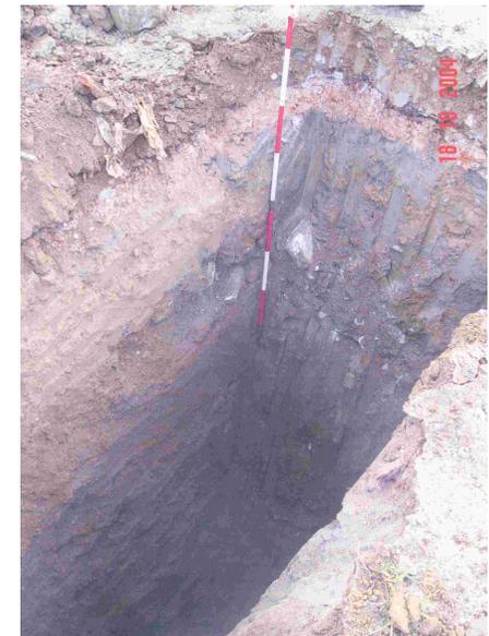
Durante il sopralluogo sul terreno sono stati effettuati rilievi di tipo geomorfologico confrontandoli con dati già in possesso dello scrivente e riferiti a situazioni analoghe in aree vicine mentre la costituzione geologica locale è stata indagata tramite l'esecuzione di due pozzetti esplorativi effettuati con l'ausilio di un escavatore e spinti fino alla profondità di circa 3,6 m dal piano campagna
