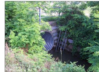
VISTA DELLA VASCA DI SEDIMENTAZIONE DI 50 mc POSTA IN PROSSIMITA' DELL'IMMISSIONE DEL TORRENTE DEL BACINO 30 NEL FOSSO COLATORE DEL PILONE
