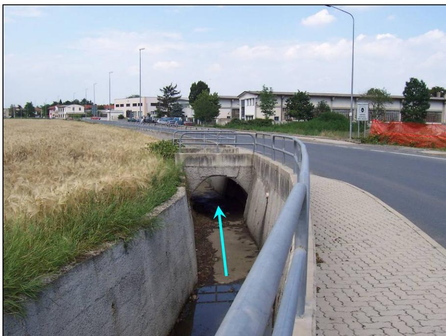
Fotografia 30 – Vista di un attraversamento con sezione di deflusso difforme da quella riscontrata nel progetto.
