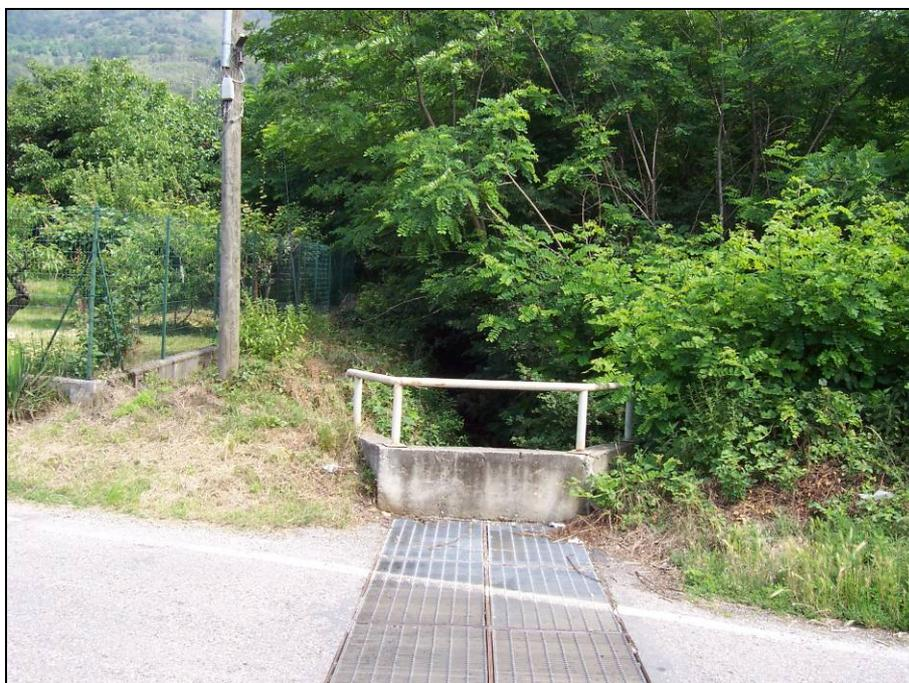
Fotografia 6 – Attraversamento del torrente del bacino 13 sotto la strada di accesso alla località Grangiotto.
