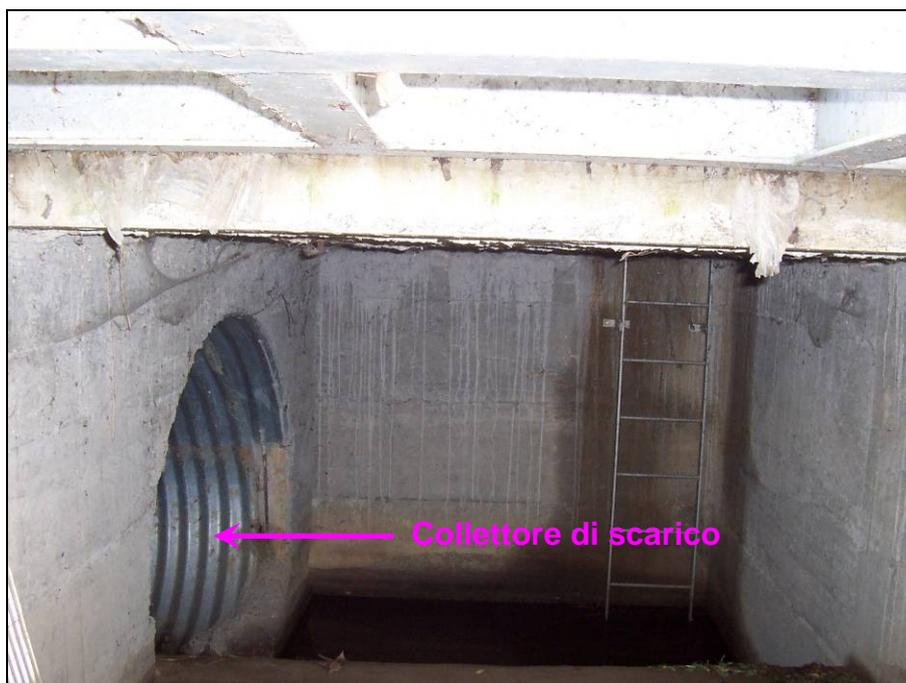
Fotografia 23 – Vista interna della vasca di raccolta delle acque provenienti dalla pista tagliafuoco.
