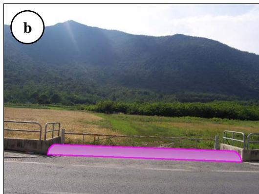
Figura 17 - Attraversamento "1" sul quale si prevede la realizzazione di un dosso artificiale di altezza minima pari a 30 cm ("a" stato di fatto, "b" ipotesi di dosso artificiale).
