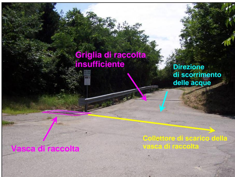
Figura 27 - Schema della raccolta delle acque provenienti dalla pista taglia-fuoco.
