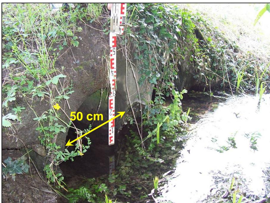
Fotografia 4 – Vista dell'attraversamento utilizzabile come scolo delle acque di esondazione del torrente Vangeirone, l'attraversamento è composto da due tubazioni da di diametro 50 cm.
