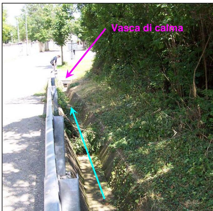
Fotografia 21 – Canaletta di raccolta in cls delle acque provenienti dalla pista tagliafuoco.
