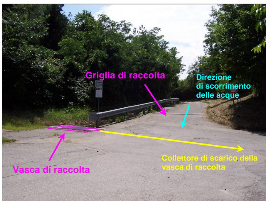
Fotografia 24 – Schema della raccolta e della canalizzazione delle acque provenienti dalla pista tagliafuoco.
