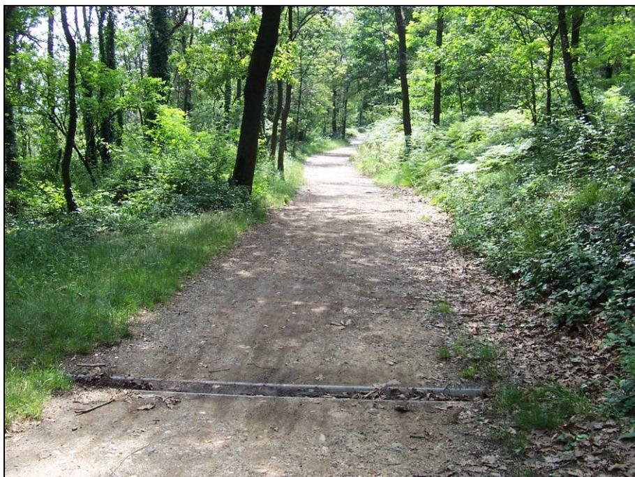
Fotografia 17 – Canalina di scolo posta sulla pista tagliafuoco (la canalina contraddistingue il punto dal quale inizia il contributo delle acque provenienti dai bacini posti a monte della pista tagliafuoco).
