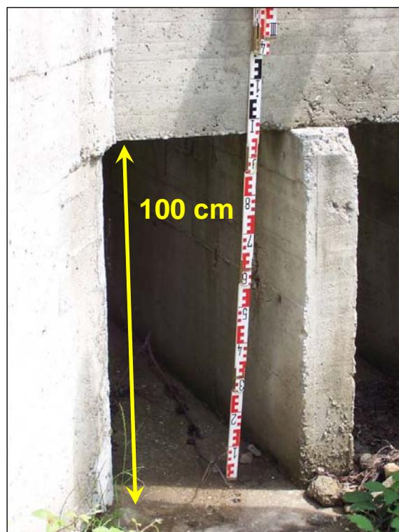
Fotografia 8 – Attraversamento del torrente del bacino 13 sotto la strada di accesso alla località Grangiotto composto da due canali a sezione rettangolare di larghezza 50 cm e di altezza 100 cm.
