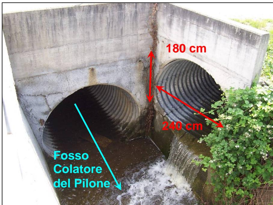
Fotografia 33 – Immissione del torrente del Bacino 30 nel Fosso Colatore del Pilone.
