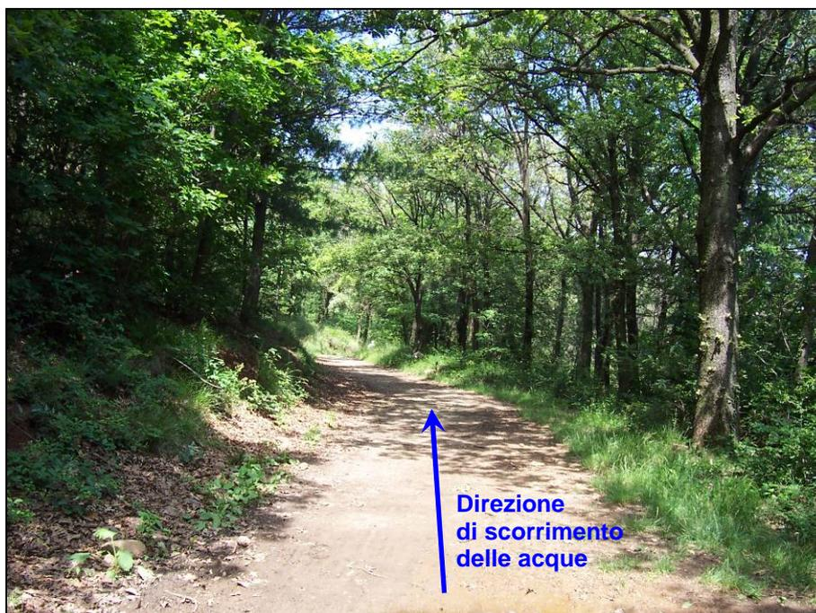
Fotografia 16 – Vista della pista tagliafuoco sulla quale ruscellano le acque dei bacini idrografici posti a monte portando contributo di portata al Fosso Colatore del Pilone.
