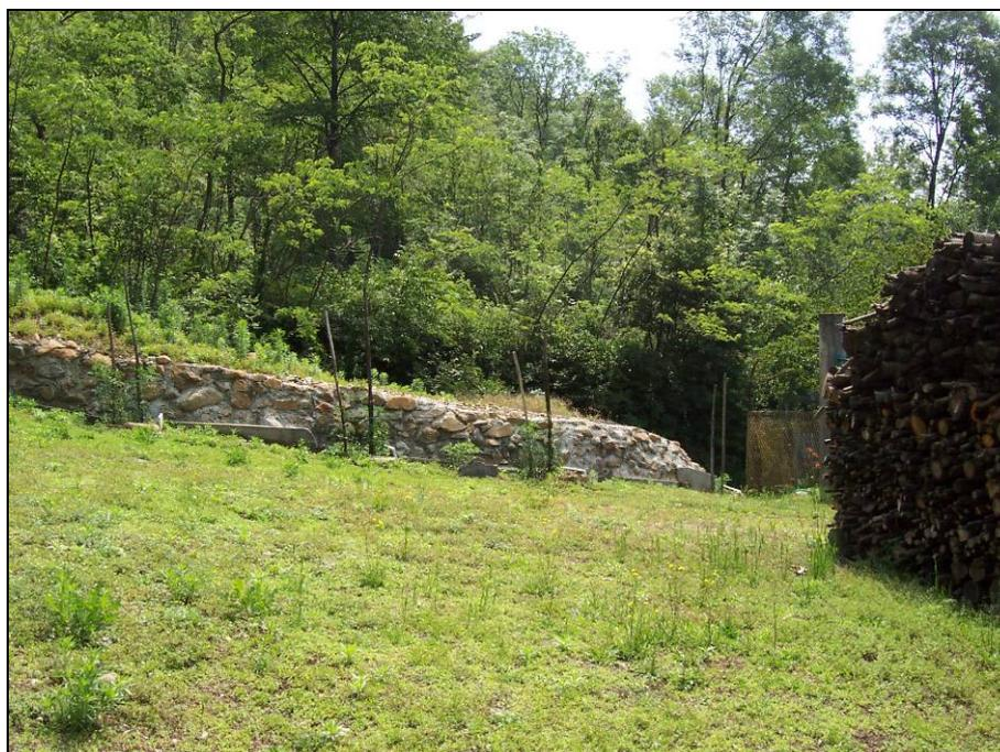
Fotografia 12 – Scogliera in massi cementati a monte della località Grangiotto posta in destra idrografica del torrente del bacino 13.
